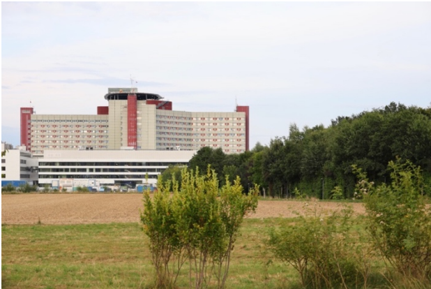
Bild 1: Feld und Klinikpark am rechten Bildrand werden dem Neubau der Uniklinik weichen müssen
